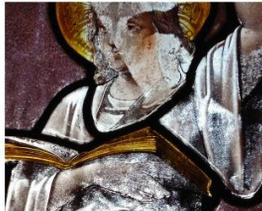
La dépose des verrières sera particulièrement délicate, les scellements et mastics semblant très solides et particulièrement résistants. Les interventions concernent en particulier l'élimination maximale des plombs de casse. Cette opération
